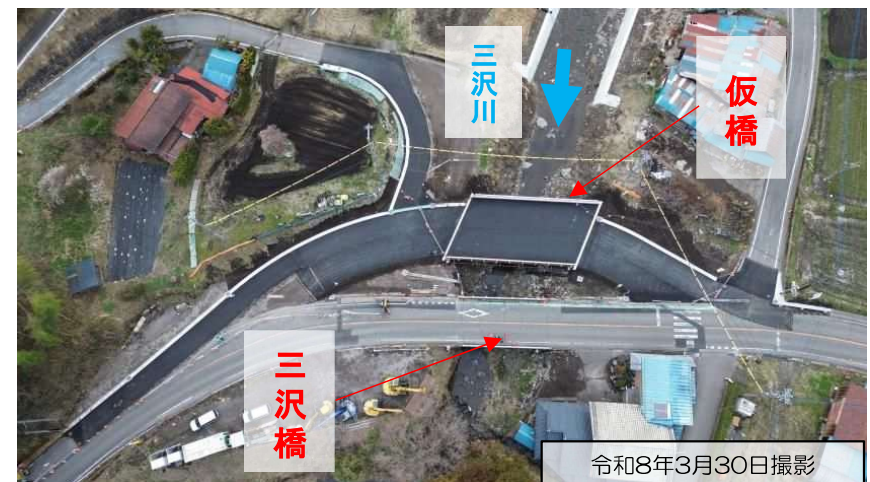
付替道路工 施工状況
