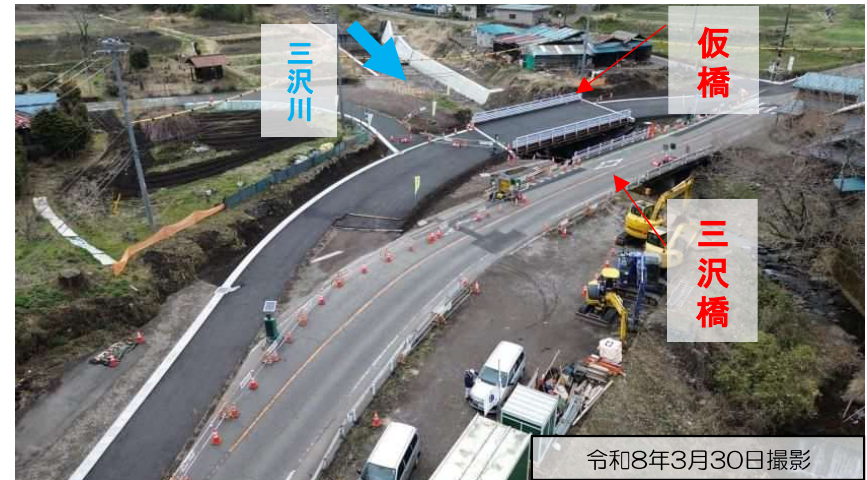
三沢橋を上空から
