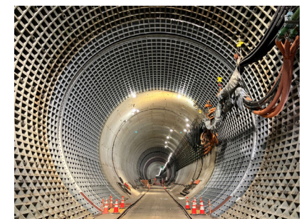
写真⑨：機内覆工完了
