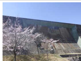
足尾砂防堰堤と桜
