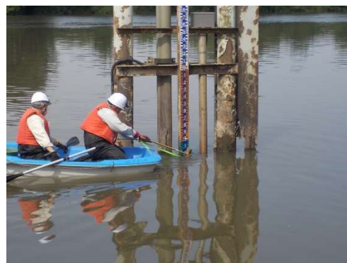
写真 5-4 水位計点検状況
