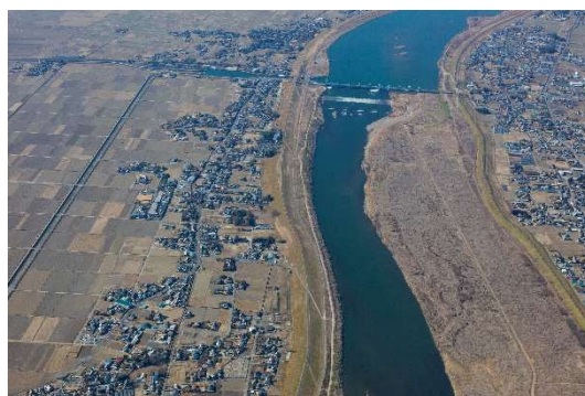
利根大堰下流
