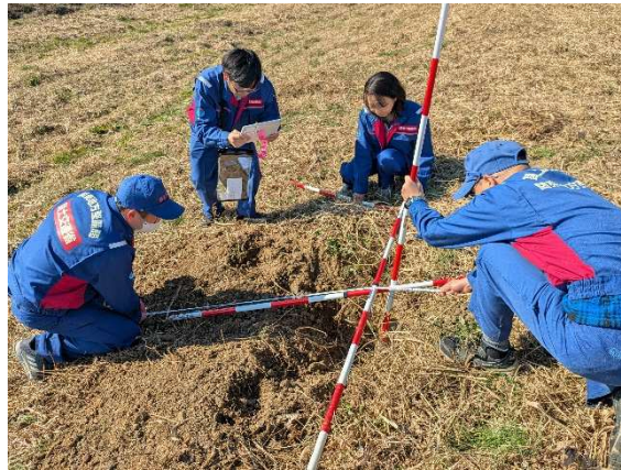
写真 5-8 堤防点検実施状況
