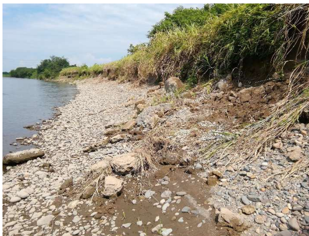
写真 6-1 河岸侵食の対策状況
