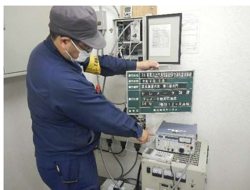
写真 5-5 テレメータ装置点検状況
