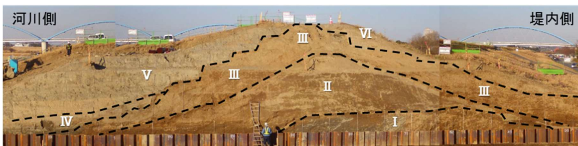
写真 6-3 堤防開削調査（平成 26 年度御所沼排水樋管改築）の例
