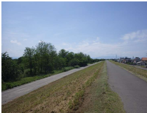
写真 3-3 河道内樹木繁茂状況
