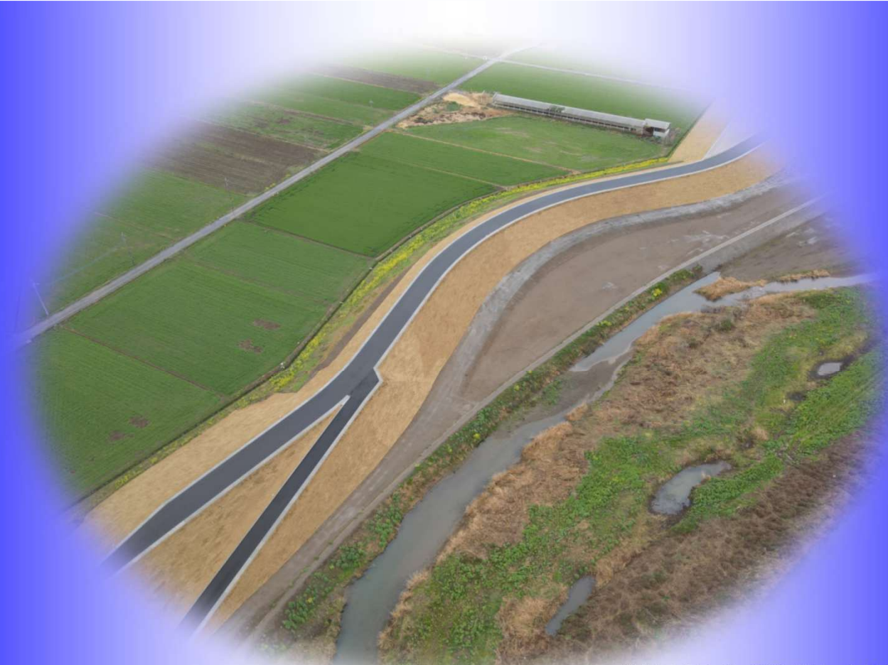
旗川改修事業 築堤(嵩上げ・拡幅)状況 (佐野市村上町地先)[令和8年3月撮影]
