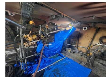
写真④：先受け鋼管の打設状況
