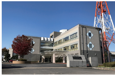
下館河川事務所
