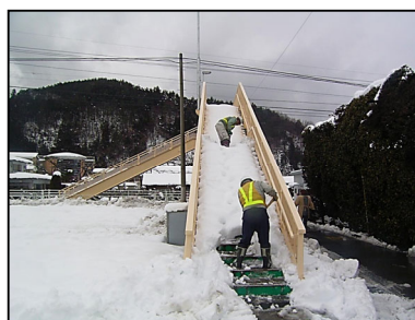
〈歩道橋 人力除雪〉 (小沼歩道橋)
