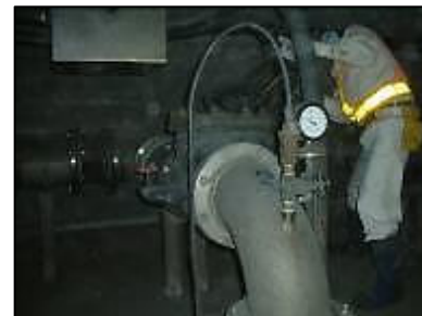
〈道路排水設備（機能点検）〉
