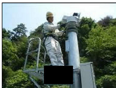
〈CCTV（機能点検）〉
