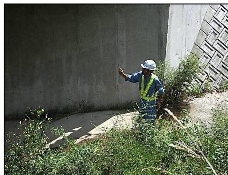
〈道路施設の定期巡回〉
