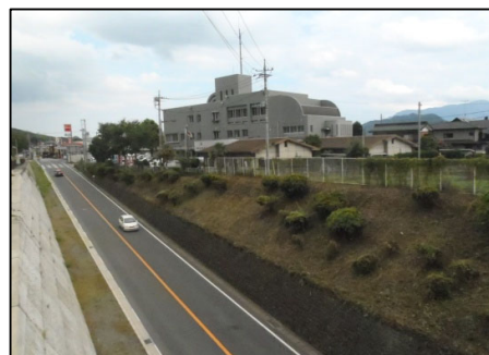
〈除草（法面）実施後〉
