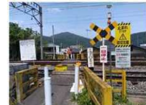
事例：第4種踏切（皆野町内）
