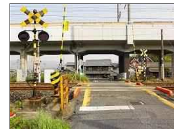
遮断機・警報機の整備
