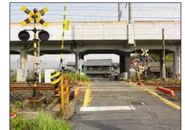
遮断機・警報機の整備
