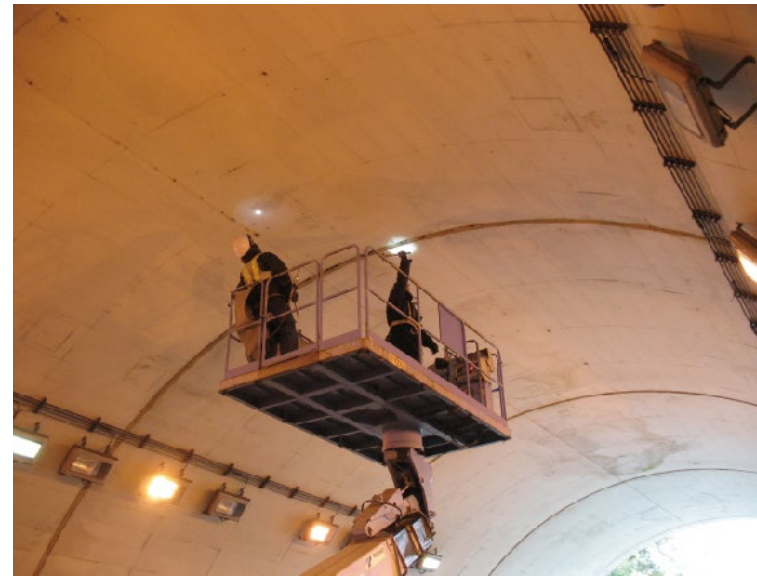
国道127号勝岩トンネル（南房総市二部）
