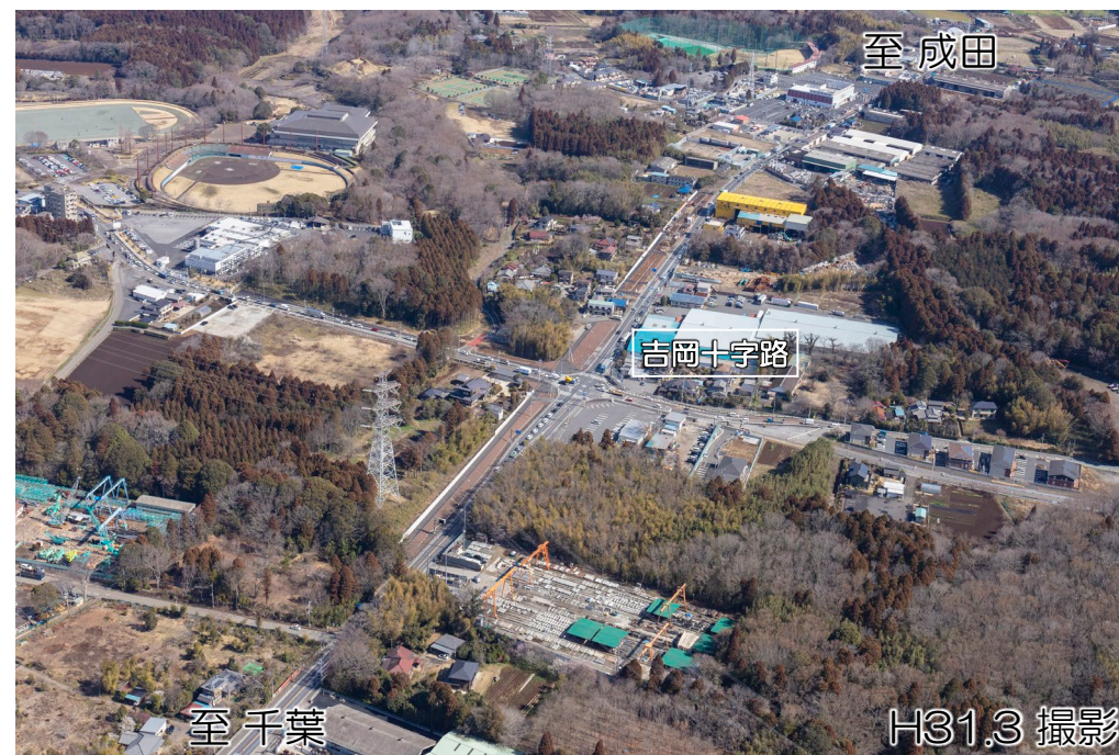
■写真① 吉岡十字路口交差点付近
