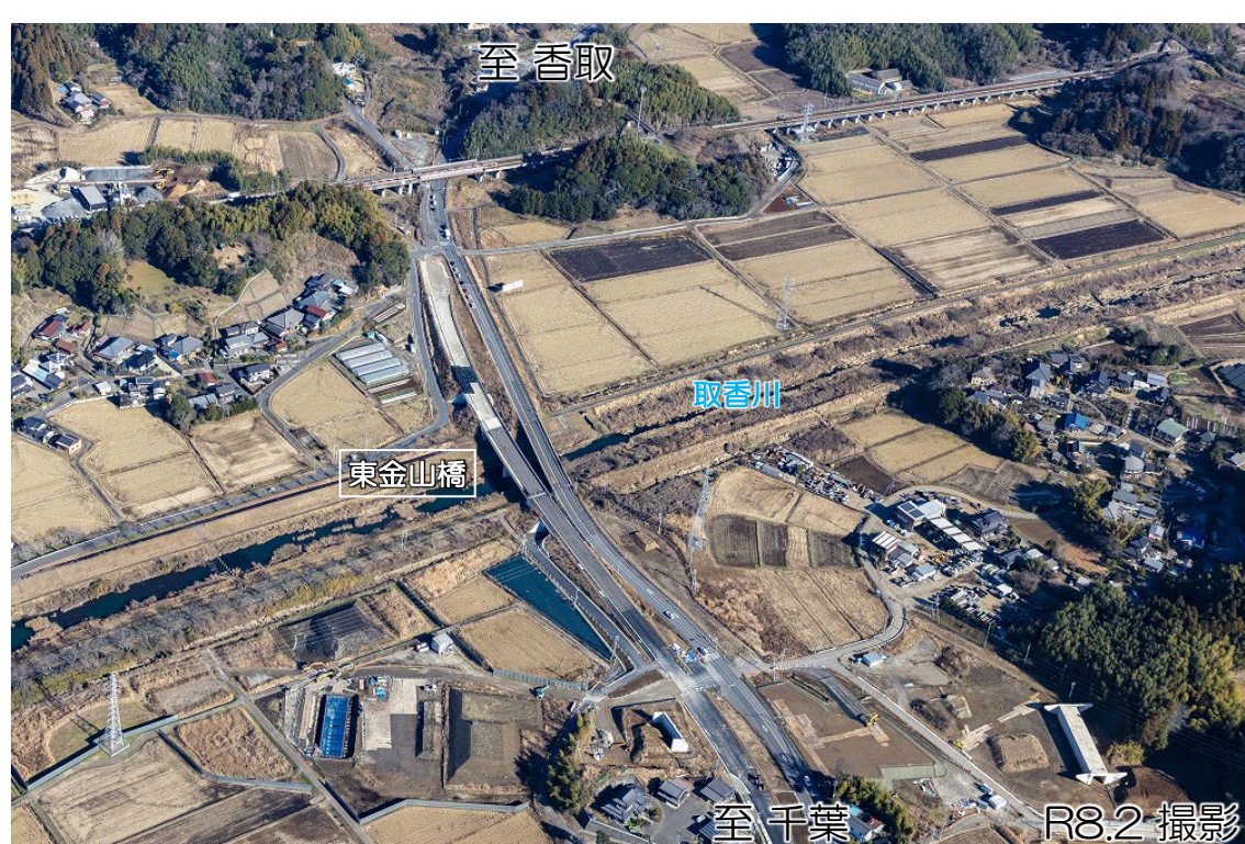
写真② 東金山橋付近
