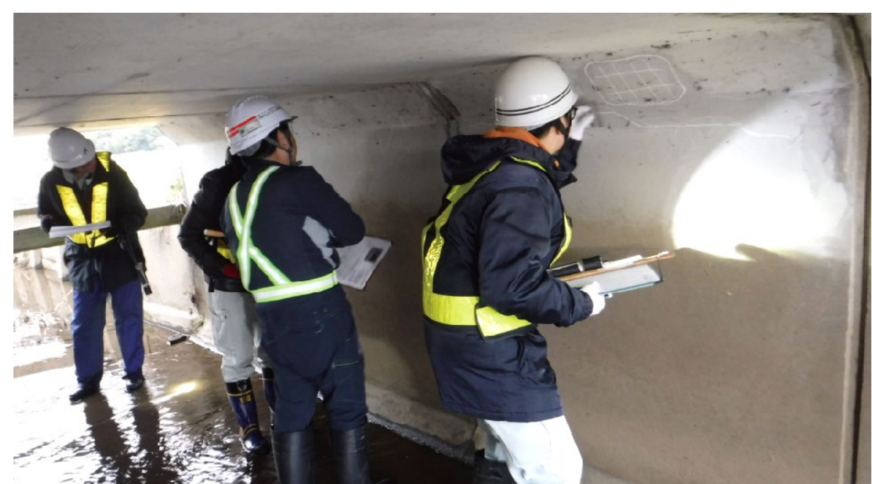
橋梁点検実習（近接目視点検の状況）
