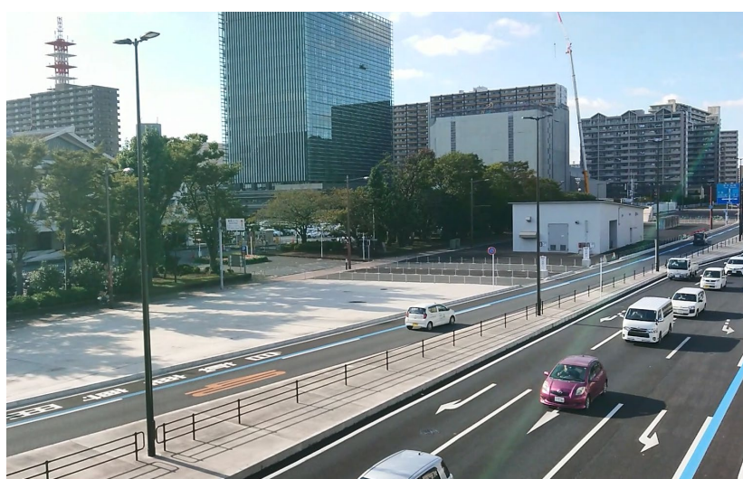
【通常時】 千葉市役所前上部空間
