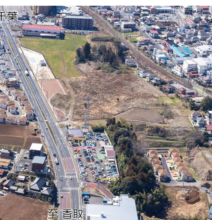
市不動ヶ岡付近(4車線開通済み)
