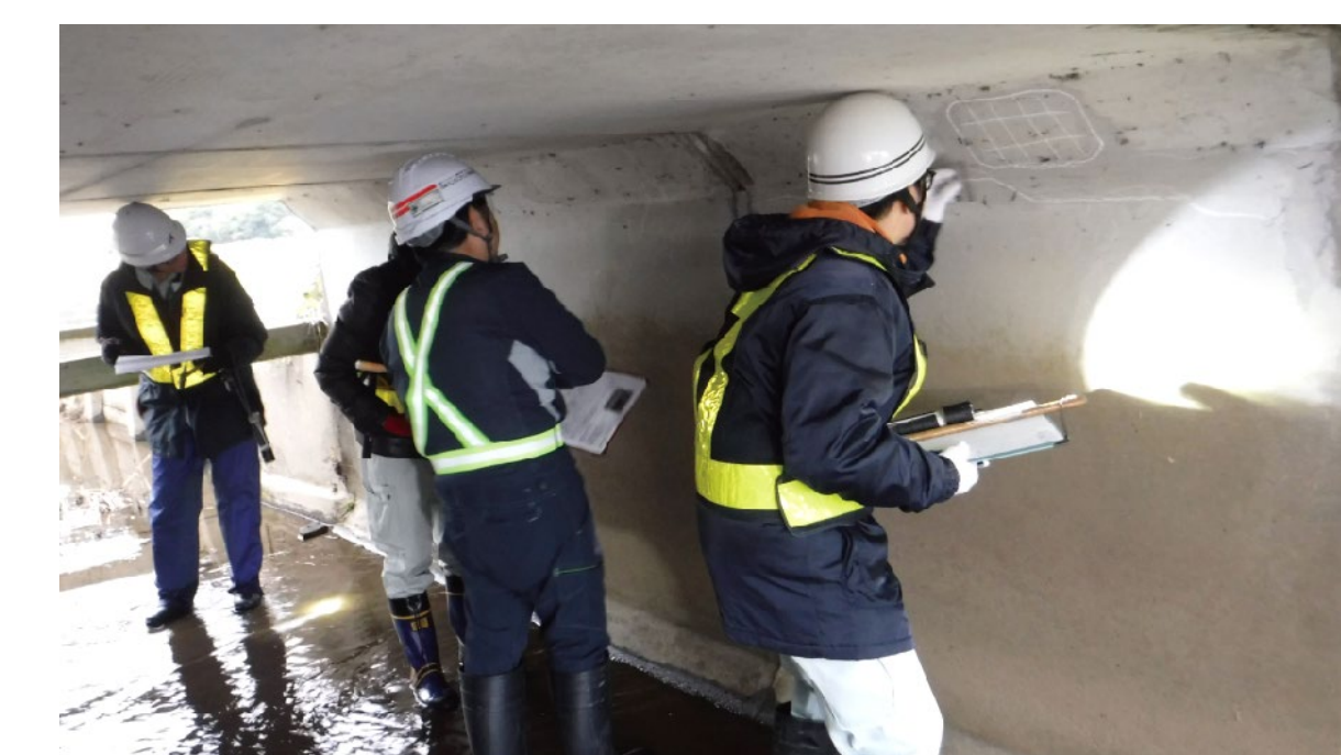
橋梁点検実習（近接目視点検の状況）
