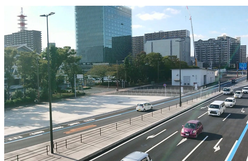
【通常時】 千葉市役所前上部空間
