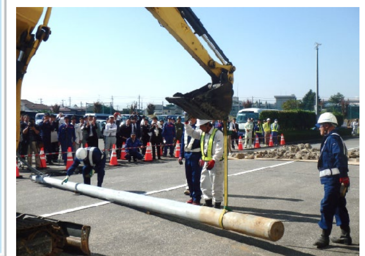
倒壊電柱処理 ※船橋防災センターで実施
