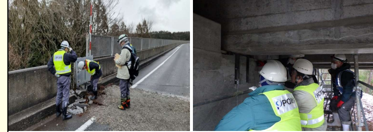
現地点検調査状況
