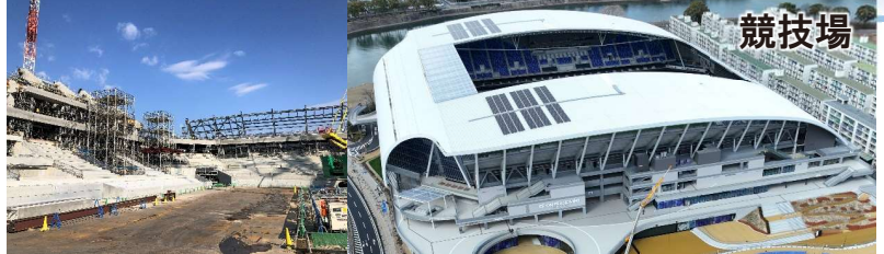
プレキャストPC造(柱・梁・段床板) プレキャストPC造で部材を規格化し工期短縮や作業の省力化を実現
