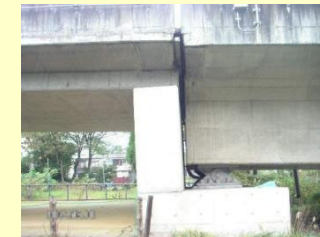
伸縮装置取替
