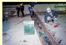
軸力導入状況
