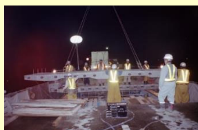
プレキャスト床版の夜間架設
