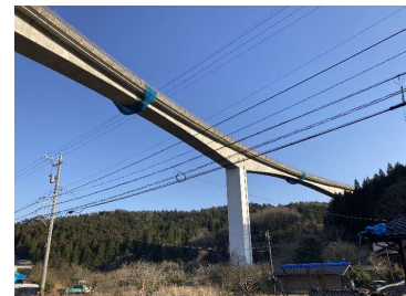
落下防止ネット設置状況
