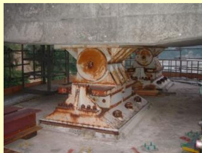
交換前の鋼製支承
