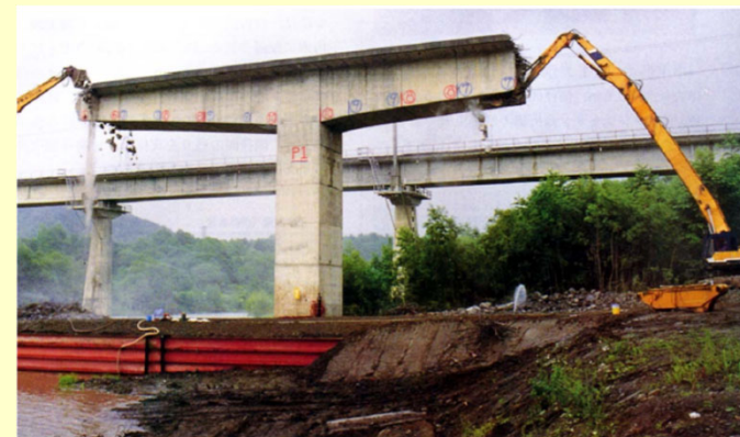
張出し部解体状況 (写真奥が鉄道橋)
