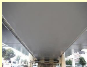
施工後（箱桁下面に繊維補強）
