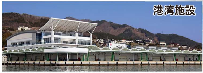
プレキャストPC造(柱・梁・床板) 高強度で緻密なプレキャストPC造により塩害対策を行い長寿命化を図る
