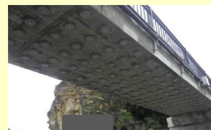
流電陽極設置完了
