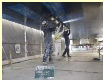
炭素繊維シート貼付け
