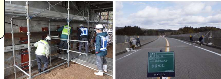
A1橋台 縦壁部鋼材設置状況
