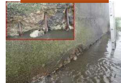
橋脚基部の破損
