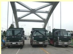
載荷試験状況
