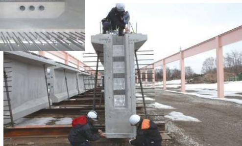
T桁断面の出来形計測
