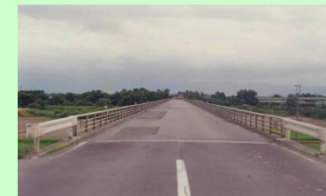
床版取替え施工前
