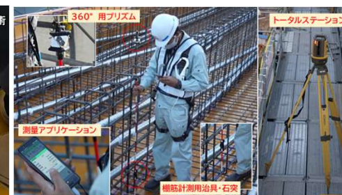
PCケーブル配置計測状況
