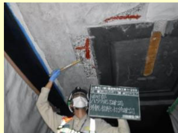
主桁コンクリートの補修
