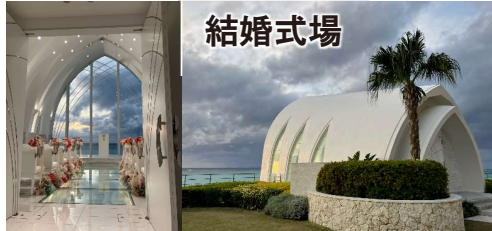
プレキャストPC造(柱・梁) プレキャストPC造により複雑な形状の部材を均一に製作
