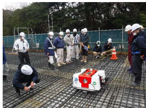
床版工事での鉄筋結束状況（i-Bridge）
