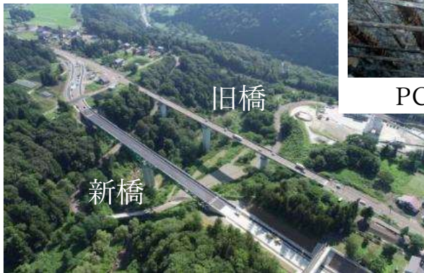
旧橋の上部工撤去にECI方式が採用
