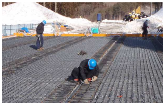
床版工事での鉄筋結束状況（従来技術）
