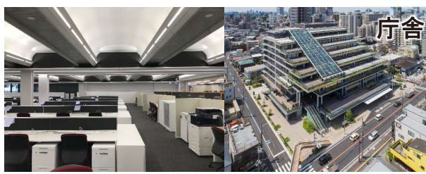
プレキャストPC造(床板) プレキャストPC床板の形状を活かした建築・設備計画と無柱の広い執務室
