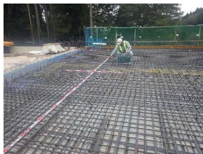
代表箇所の配筋検査を行う
