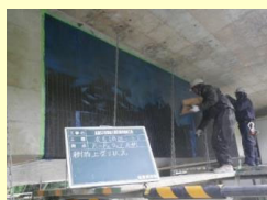
炭素繊維シート接着による補強
