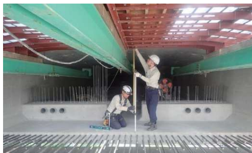
箱桁断面の出来形計測
