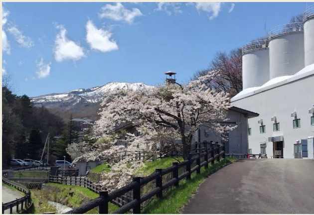
草津中和工場(春、品木ダム水質管理所内)
