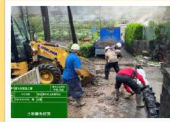
(一社)神奈川県建設業協会の災害復旧対応
