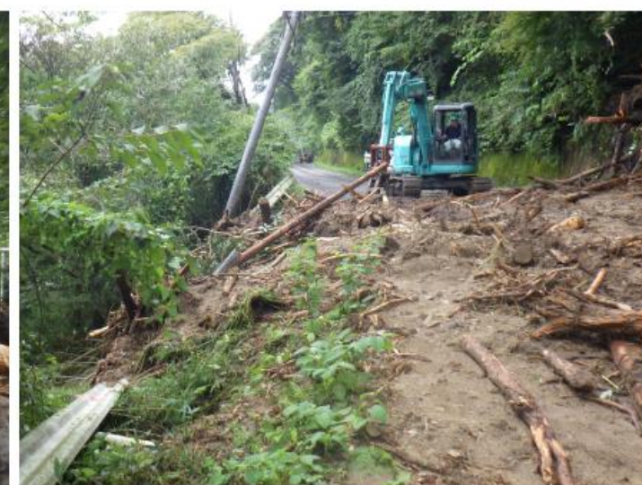
土砂崩れ崩落土砂撤去
