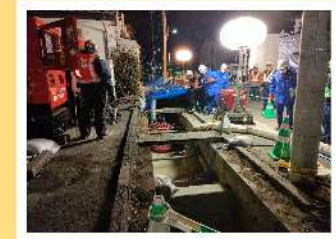
(一社)埼玉県建設業協会の災害復旧対応
