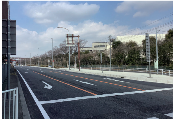
中川下水処理センター(西) 交差点(外廻り)
