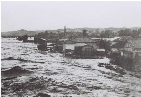
烏川筋高崎市石原地先の氾濫状況
