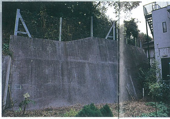
急傾斜地崩壊対策事業で造られたコンクリートの擁壁
