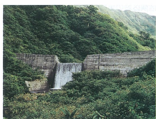
土石流を抑えるために設けられた砂防ダム
