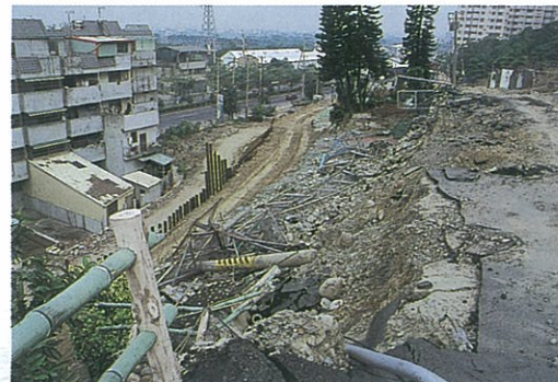
斜面を造成してつくられた住宅地(台湾)。ほぼ全壊状態。台湾大地震では2,300余名の人が犠牲になりました。
