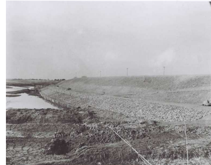
復旧された利根川の堤防
