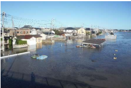
茨城県神栖市浸水状況
