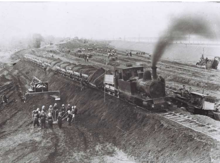
決壊箇所における当時の築堤状況
