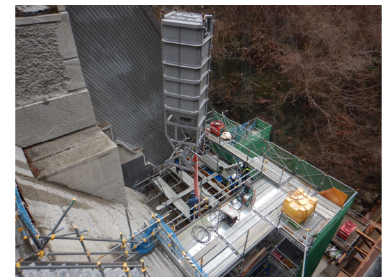
【小容量放流設備操作室工(Co打設)】 【撮影日 : R8.3.30】
