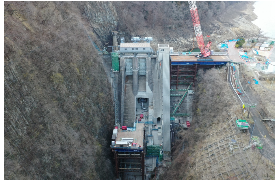
【水門据付工(放流管据付)】 【撮影日 : R8.3.24】
