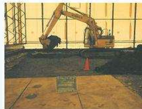
保管土掘削状況
