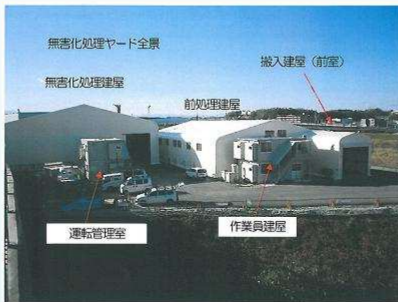
無害化処理施設(外観)
