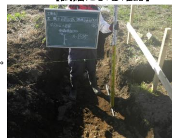
【試掘による確認】
