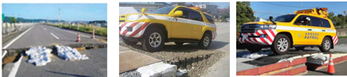
図 5-6 橋梁段差（道路啓開状況、訓練状況）
