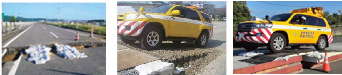
図 5-6 橋梁段差（道路啓開状況、訓練状況）
