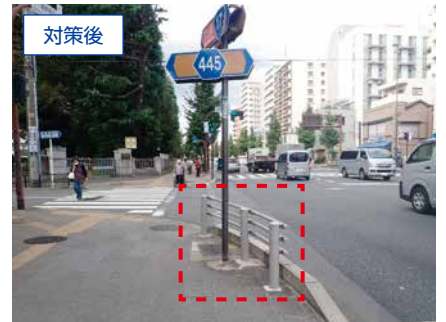
■ 防護柵の設置（車両の進入を防止）
