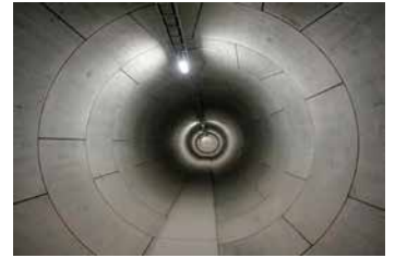
上北沢給田共同溝の整備
