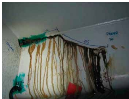
縦リブと横リブの交差部付近のき裂
