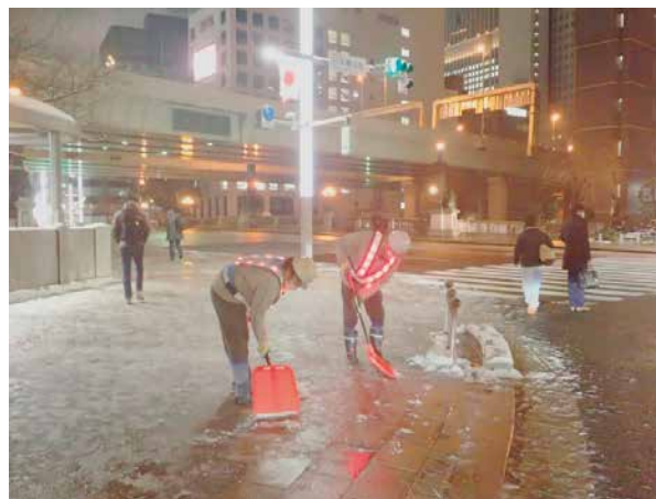
歩道除雪作業状況
