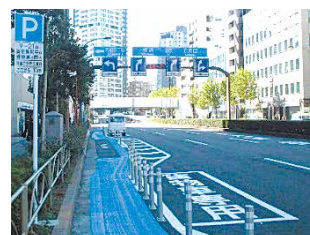
貨物車専用駐車枠
