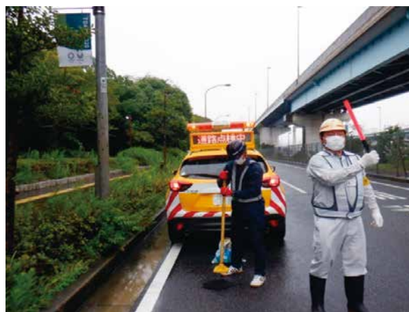
応急復旧作業状況(ポットホールの補修)
