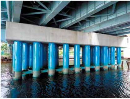
腐食部の防錆処理
