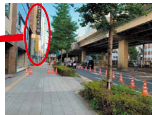
沿道建築物の外壁損傷による規制
