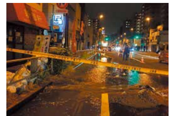
水道空気弁からの漏水による規制
