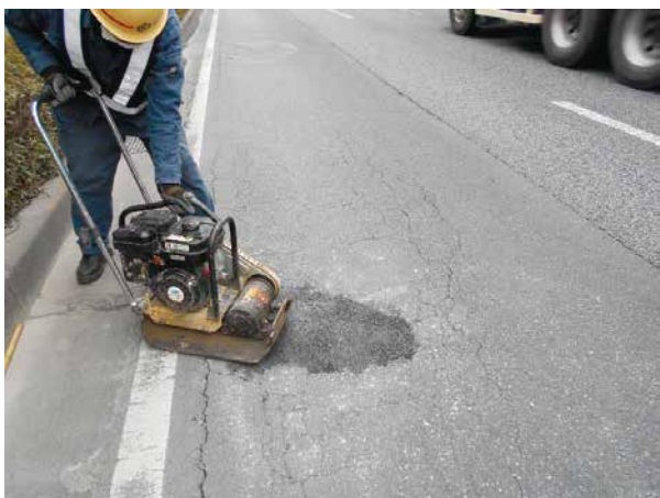
応急復旧作業状況(クラックの補修)
