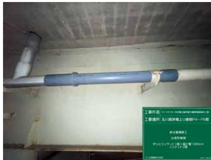
排水管の交換
