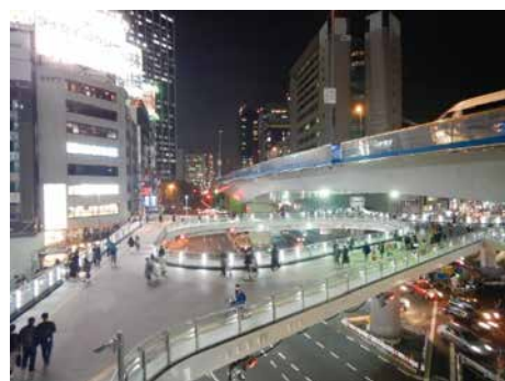
渋谷駅東口デッキ (平成31年3月開通)
