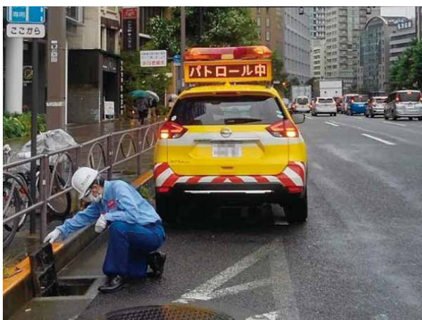
道路施設点検状況
