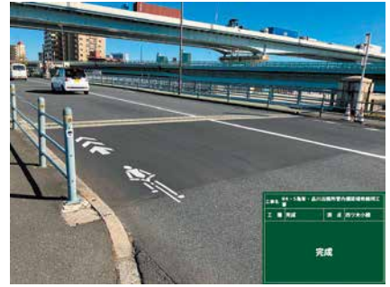
伸縮装置補修
