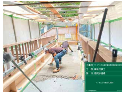
歩道橋橋面補修
