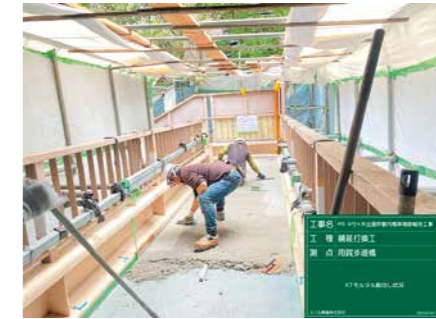
歩道橋橋面補修
