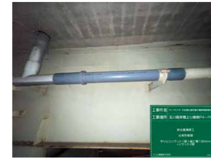
排水管の交換
