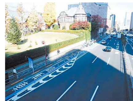
対策実施状況(全景)
