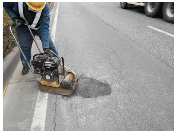
応急復旧作業状況(クラックの補修)
