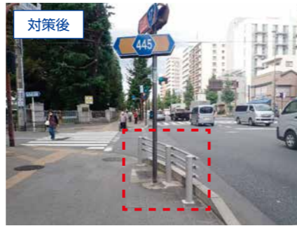
■防護柵の設置(車両の進入を防止)
