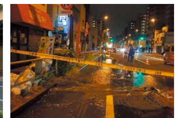
水道空気弁からの漏水による規制
