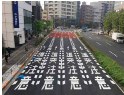
■注意喚起の路面標示(追突注意)
