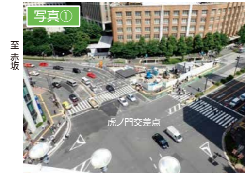
地上部現況 至新橋
