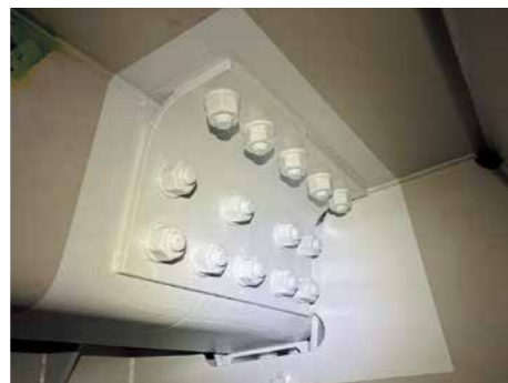
Uリブ疲労き裂補修として当て板を設置
