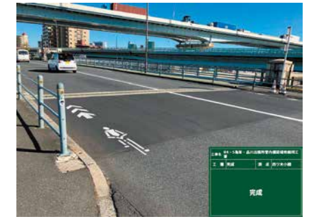
伸縮装置補修
