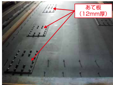
デッキプレートの疲労き裂補修として当て板を設置
