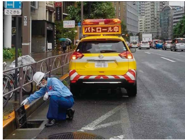
道路施設点検状況
