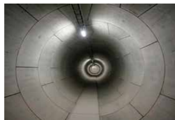
上北沢給田共同溝の整備
