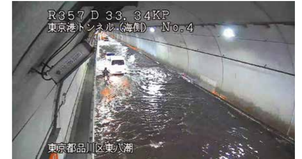
冠水状況 令和7年9月11日(国道357号 東京港トンネル 品川区)
