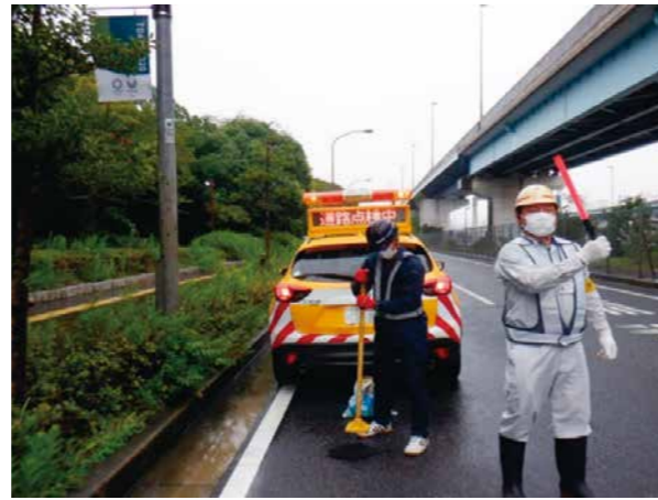
応急復旧作業状況(ポットホールの補修)
