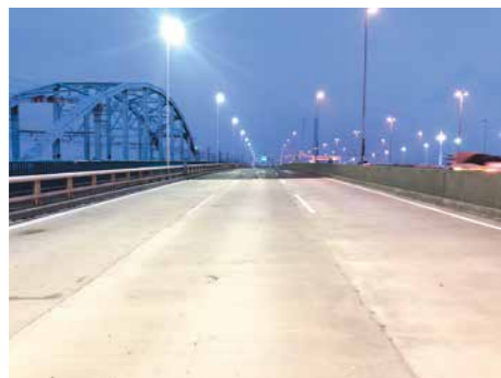
補修対策としてSFRC舗装を打設 ※1:SFRC(鋼繊維補強コンクリート) ※2:SFRC打設後に表層アスファルト舗装を施工
