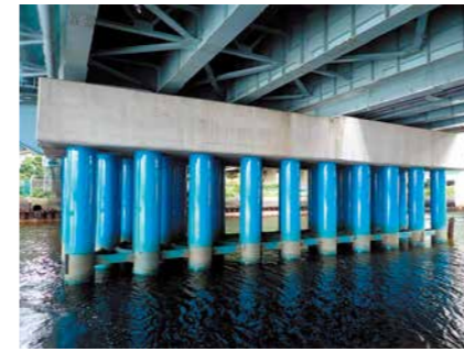
腐食部の防錆処理
