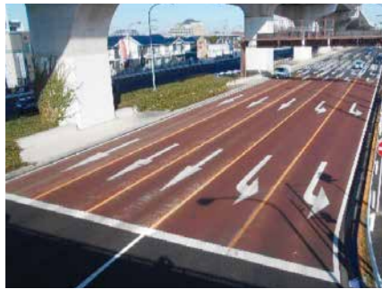
■滑り止めカラー舗装(追突事故対策)
