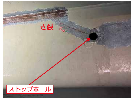
Uリブの疲労き裂補修としてストップホールを設置
