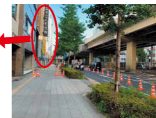
沿道建築物の外壁損傷による規制
