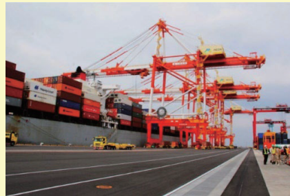
(出典)関東地方整備局HP
