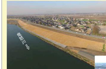
<常総市三妻地区堤防整備状況>
