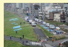
排水ポンプ車の設置
