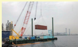
海底障害物の撤去
