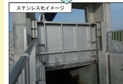
(出典) 関東地方整備局HP
