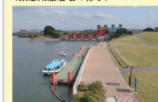
(出典)関東地方整備局HP
