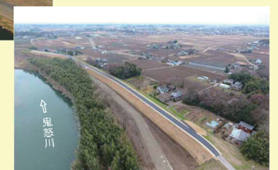
<八千代町坪井地区堤防整備状況>
