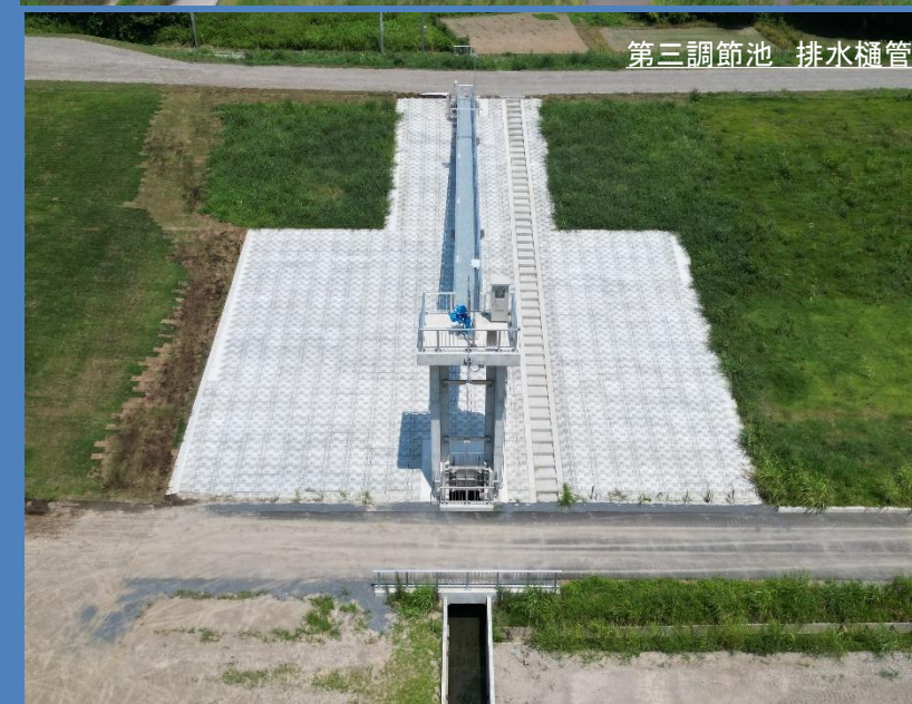
工事完了(令和7年9月)
