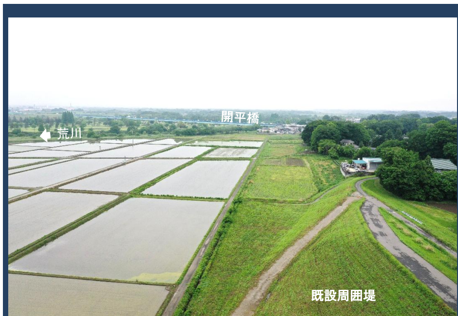
工事着手前(令和4年5月)
