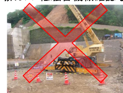
排ガス・低騒音機械確認写真
