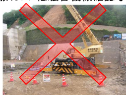
排ガス・低騒音機械確認写真
