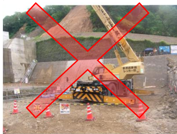
排ガス・低騒音機械確認写真
