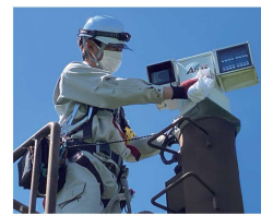
▲機械設備の点検
