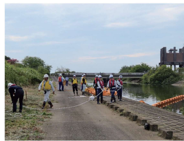
▲オイルフェンス設置
