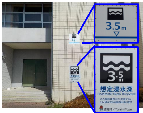
公共施設等壁面の設置状況
