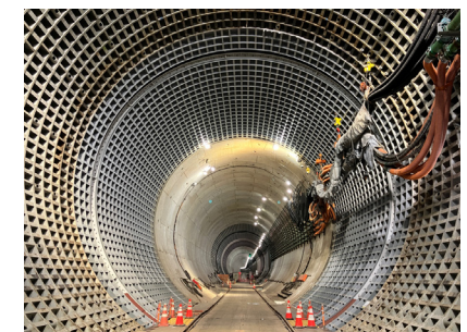
写真⑨：機内覆工完了
