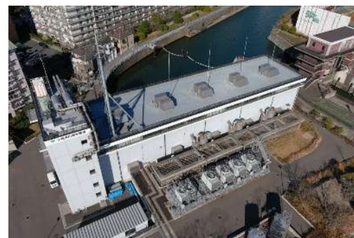
小名木川排水機場(東京都)
