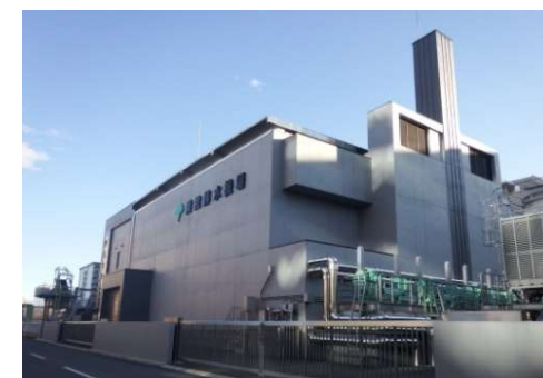
清澄排水機場(東京都)
