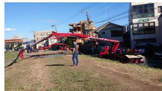
令和元年東日本台風におけるコンクリート圧送車の活躍 引用：小澤総業株式会社ウェブサイト
