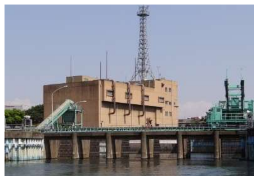
木下川排水機場(東京都)
