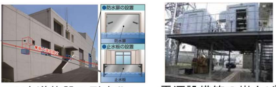
下水道施設の耐水化 電源設備等の嵩上げ
