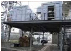
電源設備等の嵩上げ
