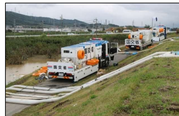
排水ポンプ車の配置状況
