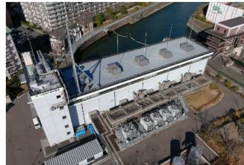
小名木川排水機場(東京都)
