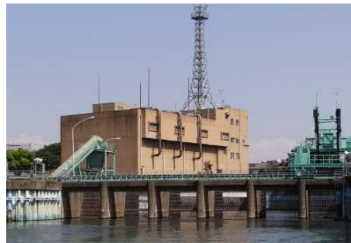
木下川排水機場(東京都)
