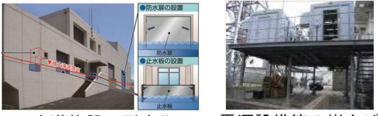
下水道施設の耐水化 電源設備等の嵩上げ
