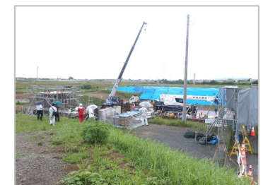
烏川流域の重要水防箇所の共同点検に参加(R7.6.23)
