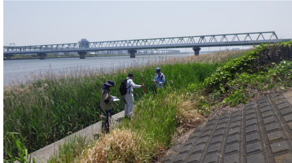
低水路における危険箇所の有無を点検中
