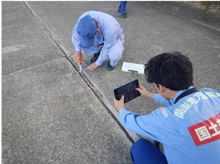
堤防天端上の段差を記録中
