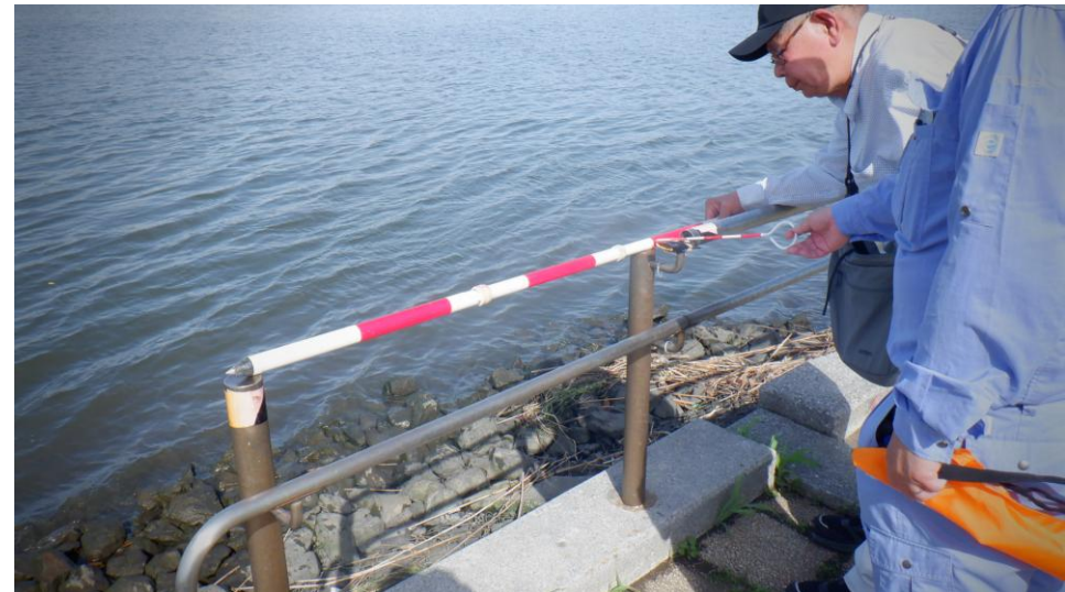
手摺りの損傷状況を点検中
