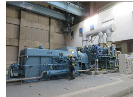
排水機場点検
