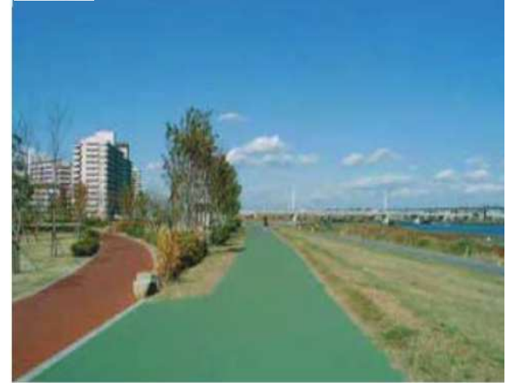
高規格堤防の整備によって市街地側は 堤防とほぼ同じ高さに盛土
