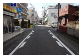
区画線 (減速ドットマーク)
