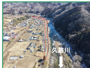
工事箇所の全景（下流から）
