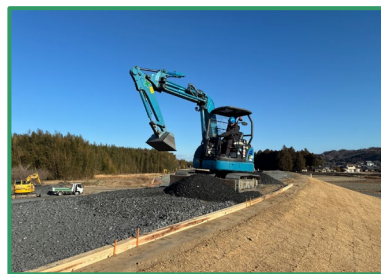
堤防天端道路の路盤を整備しています
