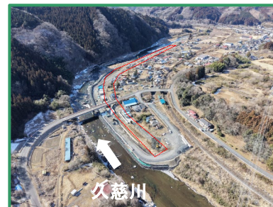
工事箇所の全景（上流から）
