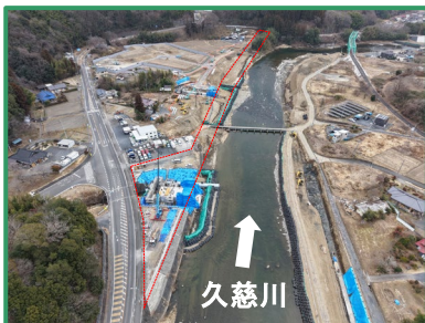
工事箇所の全景（上流から）
