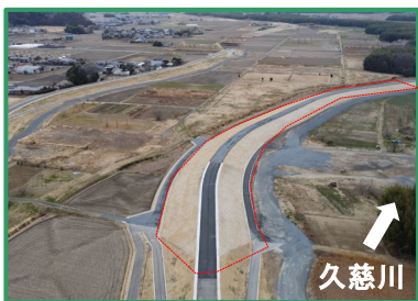
工事箇所の全景（上流から）
