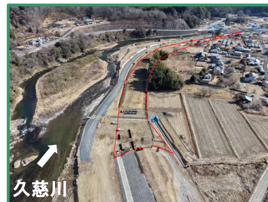
工事箇所の全景（上流から）
