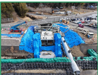
樋管のコンクリートを打設しています
