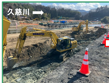
護岸(大型ブロック)の床掘りをしています
