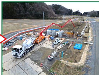
用水樋管(中流部)のコンクリートを打設しています
