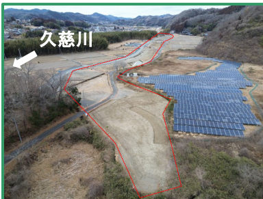
工事箇所の全景（下流から）
