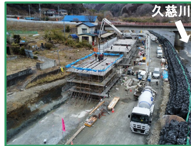
重力式擁壁のコンクリートを打設しています
