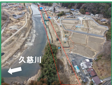
工事箇所の全景（下流から）
