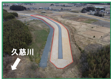
工事箇所の全景（下流から）
