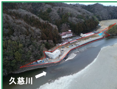
工事箇所の全景（上流から）
