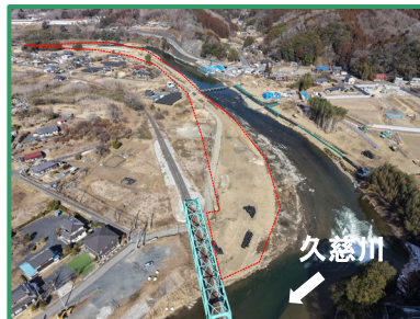
工事箇所の全景（下流から）
