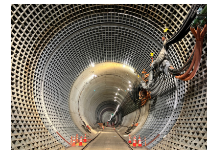
写真⑨：機内覆工完了
