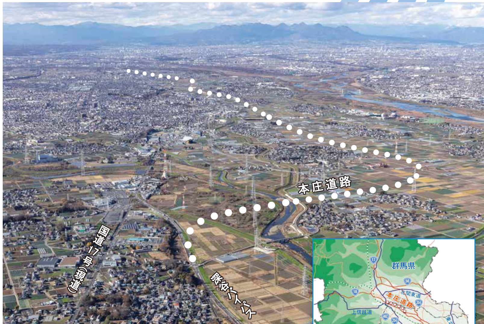
起点側より群馬県方面を望む
