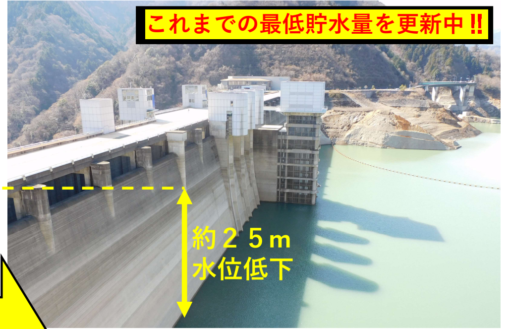
現在の貯水状況 (令和8年3月11日10時撮影)
