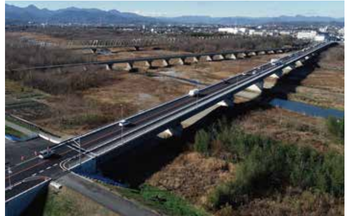
神流川橋架替区間整備状況
