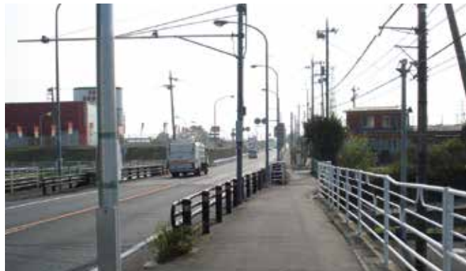
深谷バイパスが整備されている深谷市岡(東)交差点付近
