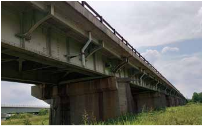
令和4年（旧）神流川橋の様子
