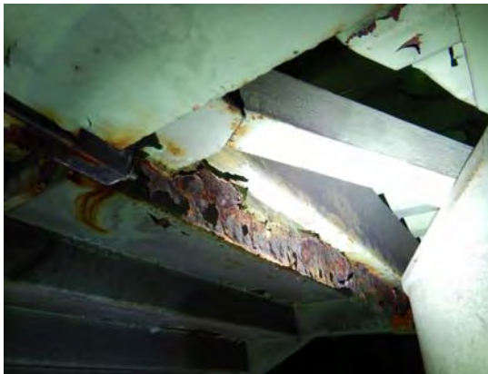
・地覆の腐食 <地覆補修>
