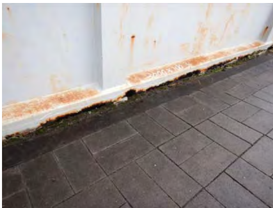
・地覆の腐食 <地覆補修>
